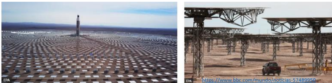
Fig 4. Planta de energía solar: Atacama, Chile.
